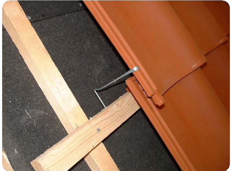
Lapetiilikiinnike kiinnitetään vesilukosta ruoteeseen.
