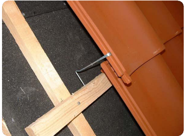
Lapetiilikiinnike kiinnitetään vesilukosta ruoteeseen.
